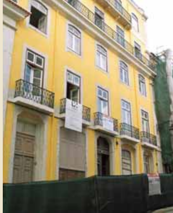
Prédio em obras de recuperação na Rua da Madalena, em Lisboa. Área foi edificada por ordem do Marquês de Pombal depois do terremoto de 1755
