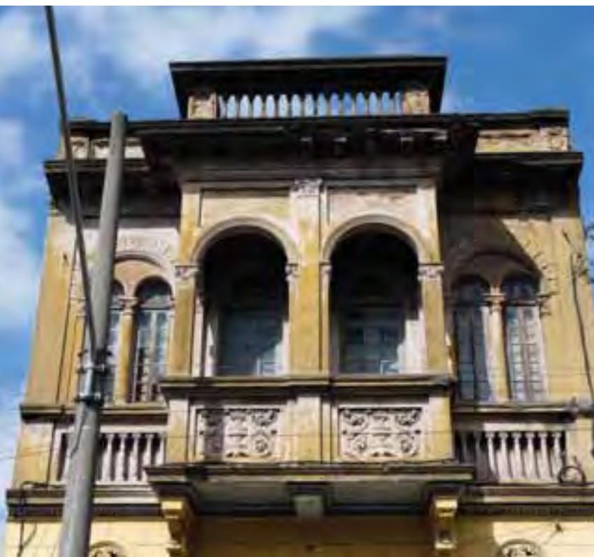
Imóvel repleto de detalhes arquitetônicos que não são encontrados em nenhum outro prédio da região (Rua Santo Amaro, nº 47 – República)
